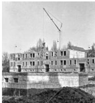
Der Baufortgang wurde mit der Kamera festgehalten. REPRO: GWG
